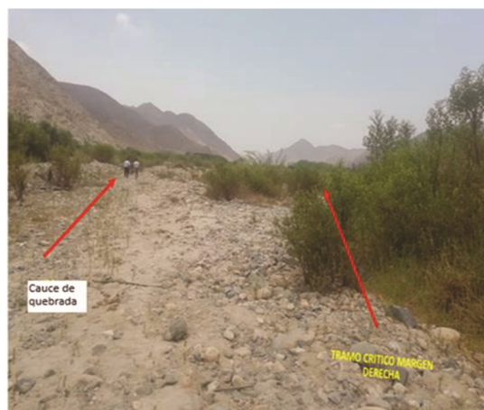
FIGURA N° 2: INSPECCIONANDO EL SECTOR CRÍTICO AUCAYCO, CAUCE COLMATADO Y CON MALEZAS. SE PROPONE LIMPIEZA Y DESCOLMATACION
